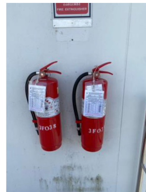
ภาพที่ 2-2 ถังดับเพลิงแบบเคมีผง และป้ายแสดงการตรวจสอบสภาพถังดับเพลิง บริเวณสถานีควบคุมความดันและวัดปริมาณก๊าซธรรมชาติ (MRS)
