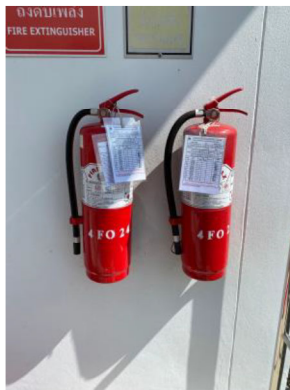
ภาพที่ 2-2 ถังดับเพลิงแบบเคมีผง และป้ายแสดงการตรวจสอบสภาพถังดับเพลิง บริเวณสถานีควบคุมความดันและวัดปริมาณก๊าซธรรมชาติ (MRS)
